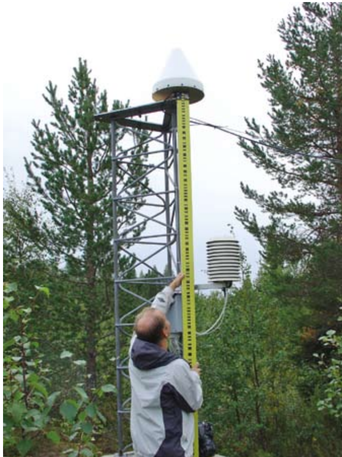
Pysyvän GPS-aseman antennin vaaitusta. Vaaitsemalla voidaan monitoroida maston liikkeitä mutta samalla yhdistää geometriset GPS-havainnot ja fysikaaliset, vaaitsemalla saadut, korkeudet. Kuva: Olli Wilkman.
